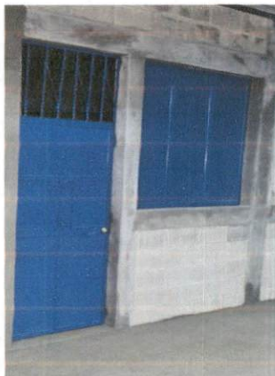
Foto 3: Instalación de puerta metálica y ventana metálica finalizado.
